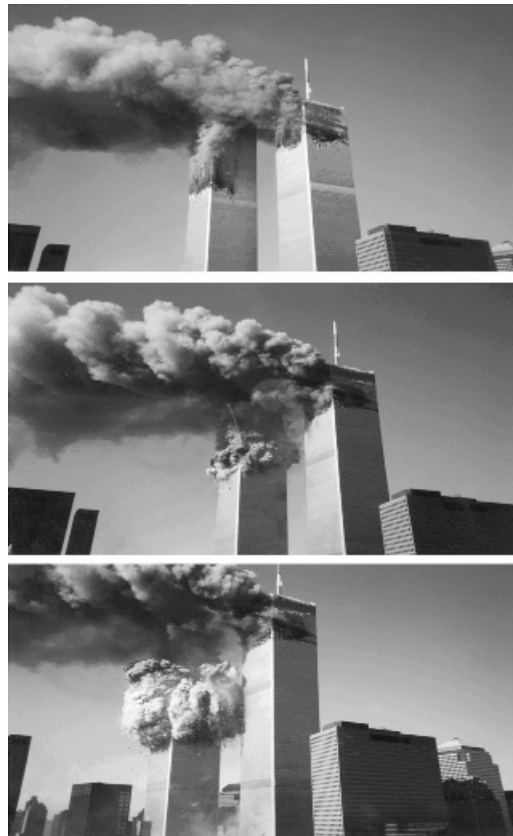
Figura 1.4 Colapso da torre sul no World Trade Center
